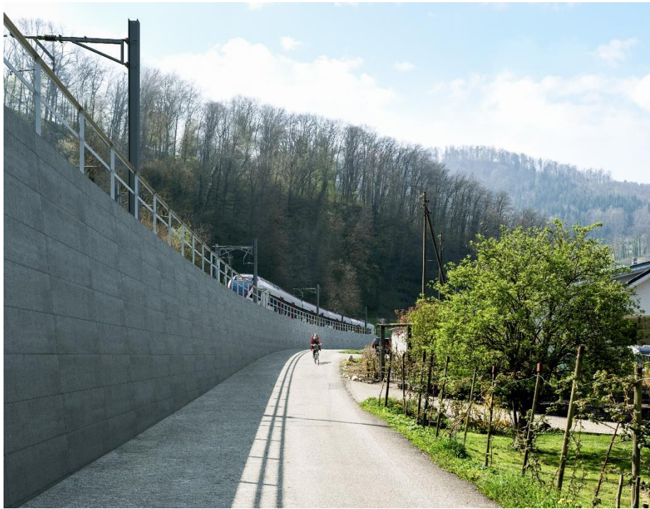
Neue Doppelspur der Schweizerischen Bundesbahnen entlang des Bahnwegs in Grellingen (Quelle: SBB)
