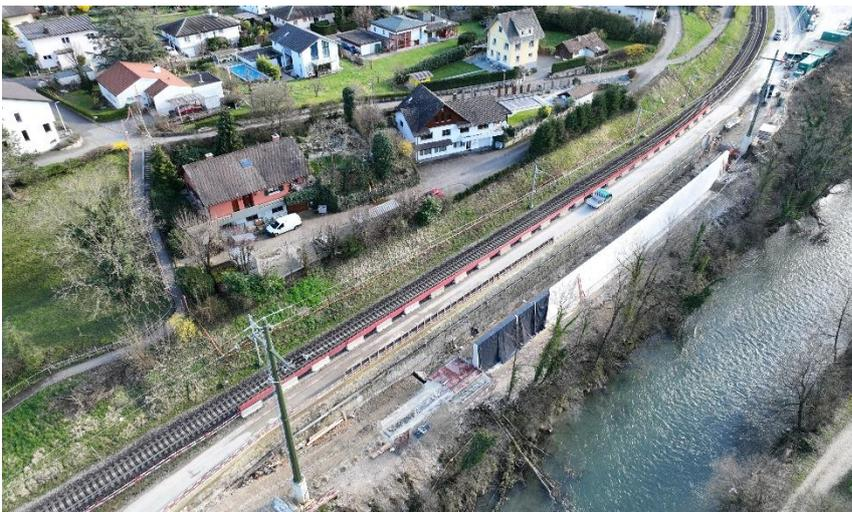
Die Betonarbeiten bei der Stützmauer Bahnweg 2 sind ebenfalls abgeschlossen. Es folgen die Hinterfüllungs- und Werkleitungsarbeiten.
