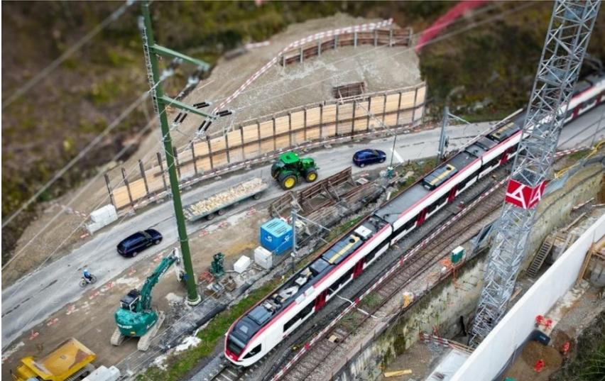
Im Abschnitt Grellingen bis Duggingen wurde der neue Bahnweg bereits zur Hälfte erstellt. Beim Bahnübergang Bahnhofstrasse wurde mit dem Felsrückbau begonnen, der Platz schafft für die spätere Verlegung des bestehenden Bahnüberganges. Die Stützmauer Bahnweg 1 ist bis auf die Hinterfüllungs- und Werkleitungsarbeiten für den neuen Bahnweg erstellt.
