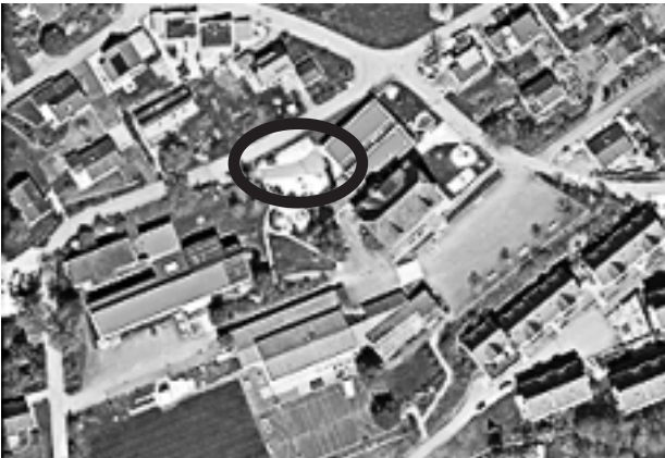
Schnitzelheizung mit Kamin und Standort der Zentrale
